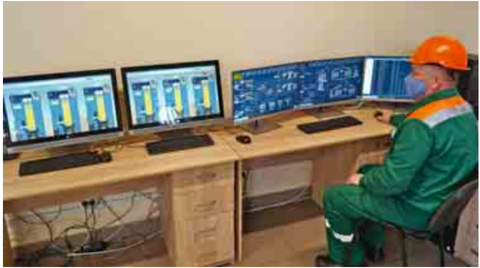
Пульт керування сушарками й елеваторним обладнанням
